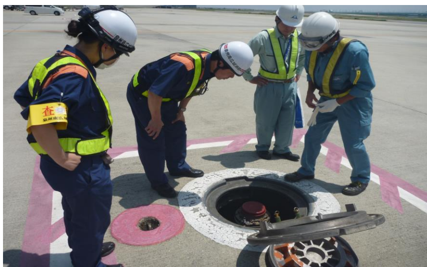
関西国際空港の航空機給油施設 立入検査の状況
