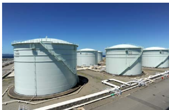
関西国際空港給油センター
